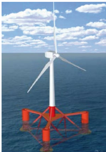
Fig. 41. – Proposta Dutch Tri-floater per il sostegno degli aerogeneratori galleggianti.
