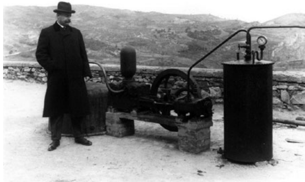
Fig. 28. – Foto del Principe Piero Conti Ginori accanto alla macchina (un motore alternativo accoppiato ad una dinamo) da lui fatta costruire nel 1904 a Larderello per produrre elettricità sfruttando il vapore geotermico. Foto: Museo della Geotermia.
